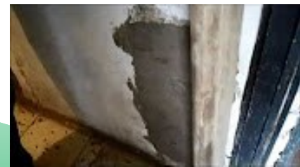
Pegar cemento nuevo a cemento viejo
